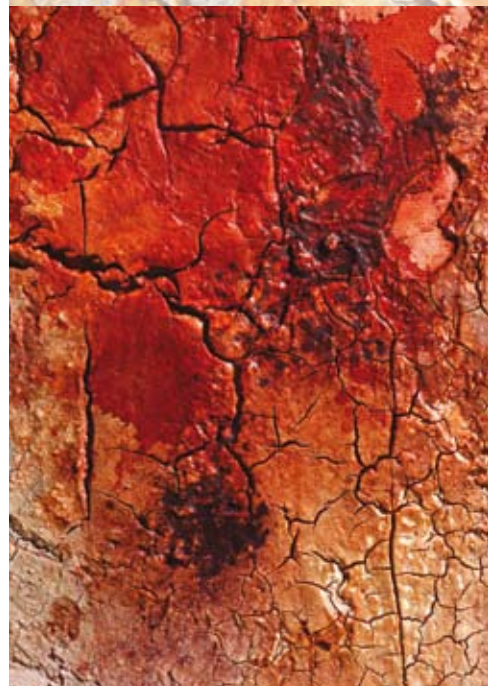
Ausschnitt aus einer gerissenen Marmorwehl-Spachtelstruktur
